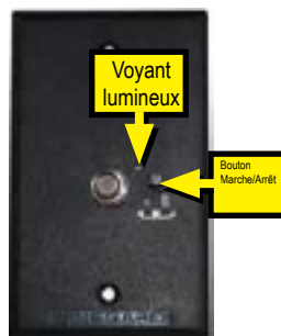
Interrupteur d'alimentation
