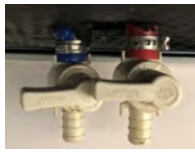
Exemple de vidange au point bas
