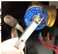
Exemple de soupape de décharge T&P
