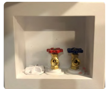
Raccords d'eau et de drainage du lave-linge
